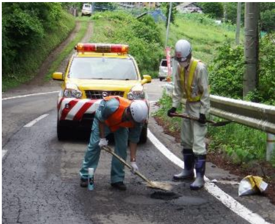
道路パトロールでの補修
