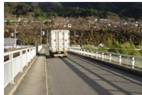
南木曾町 高瀬橋
