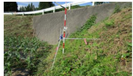
境界杭の復元状況
