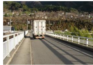
南木曾町 高瀬橋
