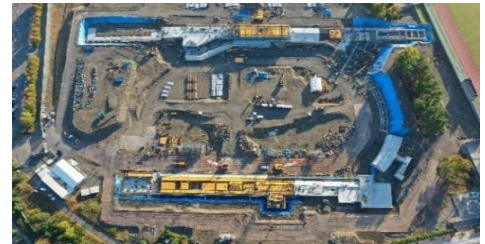
工事施工状況全景
