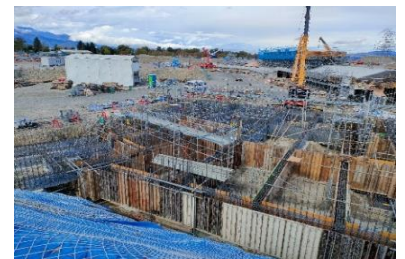
バックスタンド工事
