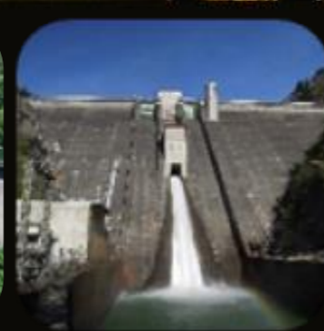
松川ダム (長野県建設部)
