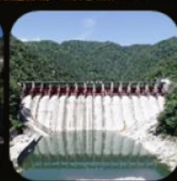
平岡ダム (中部電力)
