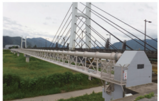
千曲川の左岸から望む水管橋(手前)
