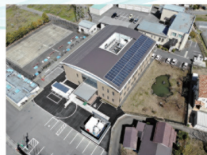
四ツ屋浄水場(長野市)
