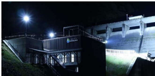
ライトアップ中の発電所
