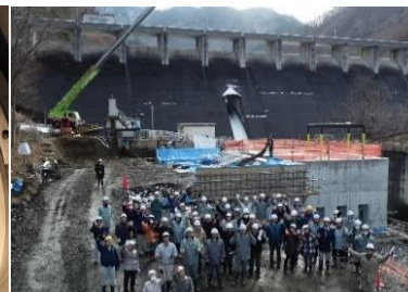
工事現場見学会
