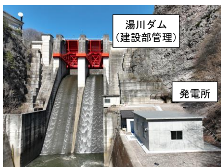
湯川ダムと森泉湯川発電所
