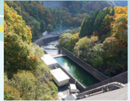
奥裾花第2発電所（2017年しゅん工）
