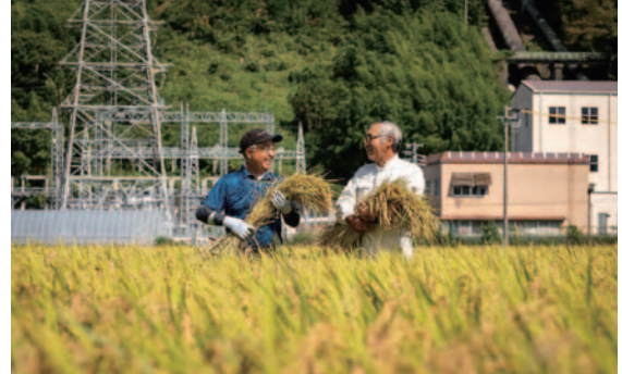
春近発電所（伊那市）
