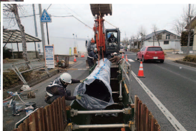
管路の耐震化工事
