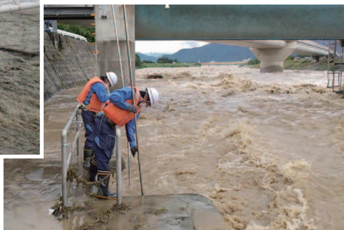
取水口での除塵作業（上田農水頭首工）
