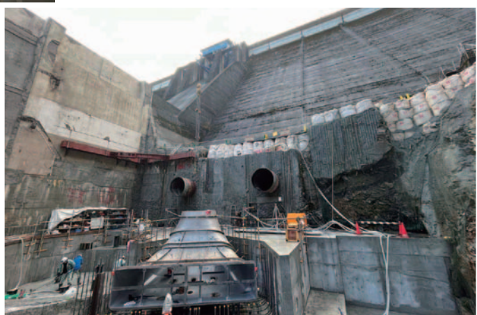
美和発電所 大規模改修
