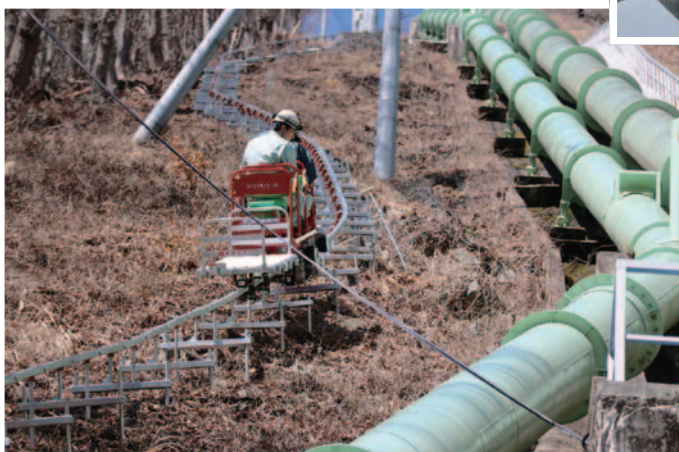
モノレールを使用した水圧鉄管の巡視
