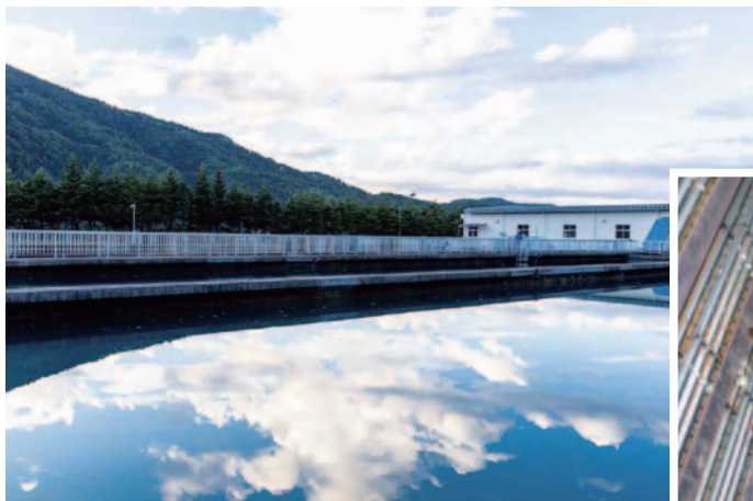
水を湛える本山浄水場沈殿池
