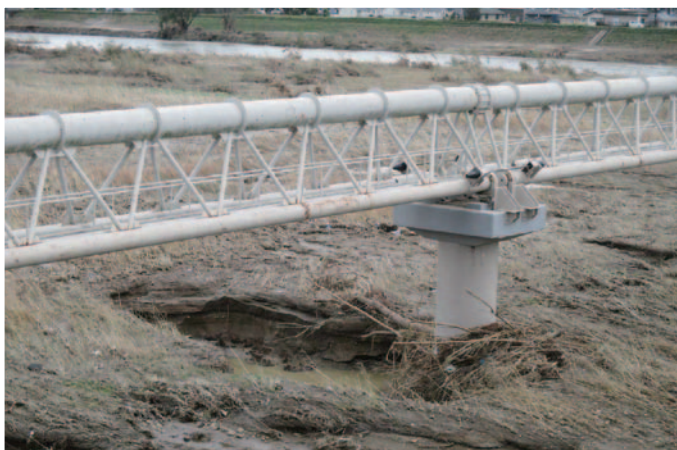
翌日の千曲川水管橋
