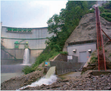
小渋第3発電所（2000年しゅん工）
