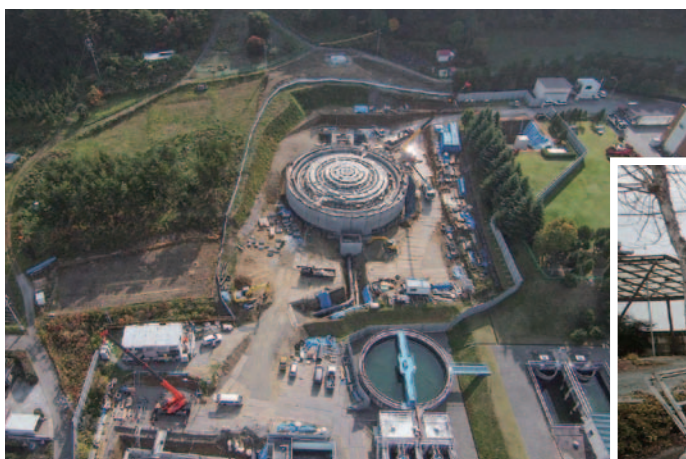
本山浄水場新浄水池築造工事
