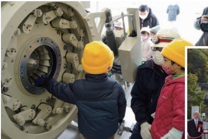
小渋えんまん発電所 現場見学会
