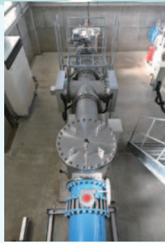
川中島水道管理事務所四ツ屋浄水場の紫外線処理設備（2012年）
