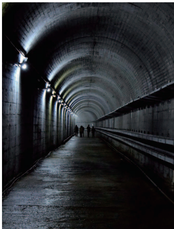
裾花発電所トンネル（長野市）
