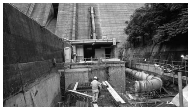
建設工事中の奥裾花第2発電所
