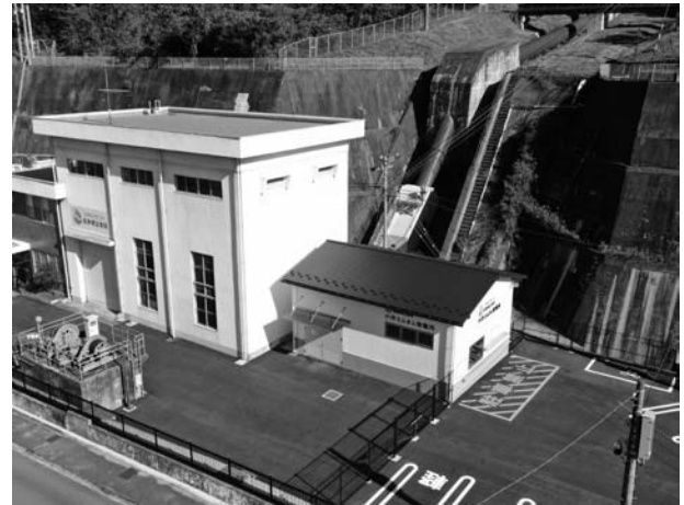
小波第2発電所と小波えんまん発電所
