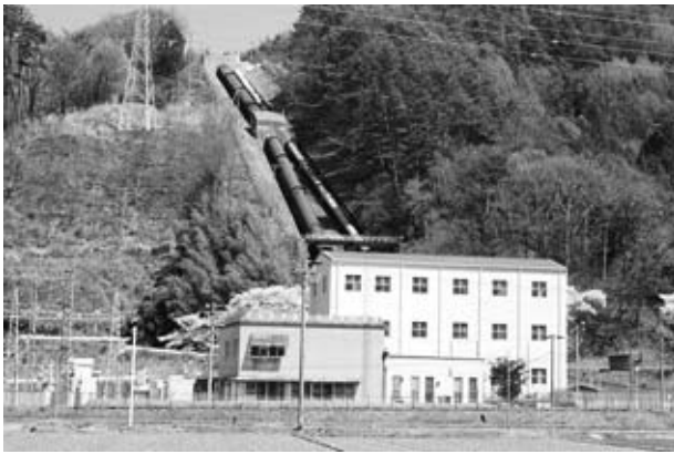
春近発電所 最大出力 23,600kW は県営最大 (大規模改修工事により 25,300kW に増強)
