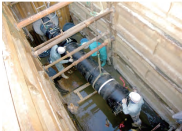
水道管の耐震化工事
