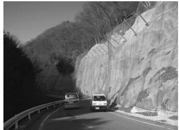
安全で快適な道路環境を支える道路防災事業
