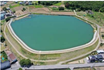
工事施工後(来光寺池:上田市)
