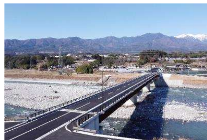
(主)伊那生田飯田線 松川町 宮ヶ瀬橋(橋梁部竣工2021.12)
