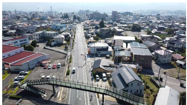
2022年度に完了した箇所 (飯田中津川線 飯田市 知久町)
