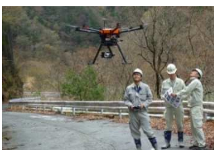
UAV測量による作業の効率化
