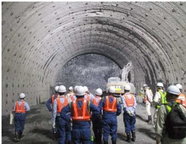
南アルプストンネル掘削状況 (大鹿村)
