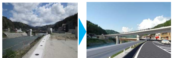
施工状況(2020年5月現在)
