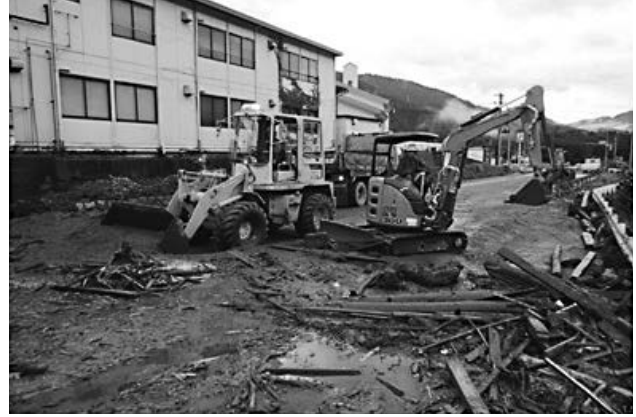
土石流災害で通行止になった国道の復旧
