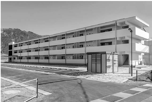
建て替えられた県営住宅アルプス団地
