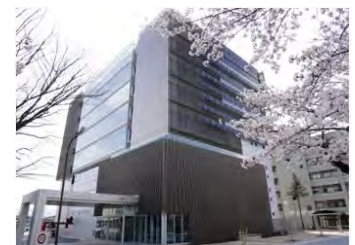
プロジェクト中核施設 「信州大学国際科学イノベーションセンター」
