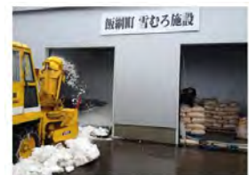
飯綱町雪室施設
