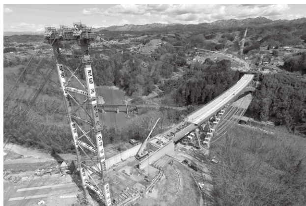
三遠南信自動車道天龍峡大橋（仮称）
