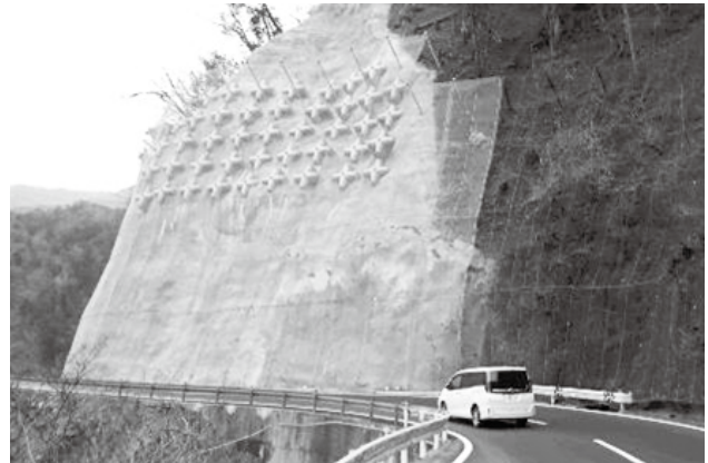
主要地方道飯田富山佐久間線道路防災工事
