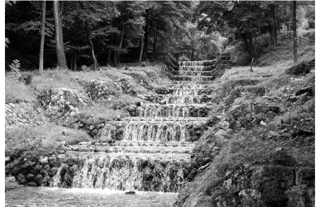
重要文化財牛伏川階段工
