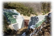
砂防堰堤(坂城町成久保)
