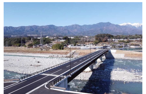
(主)伊那生田飯田線 松川町 宮ヶ瀬橋(橋梁部竣工 2021.12)
