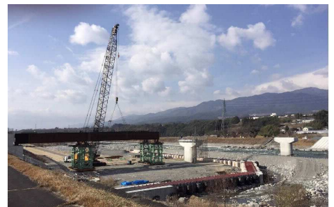
(主)伊那生田飯田線 松川町 宮ヶ瀬橋 (施工中 2019.1)
