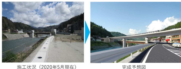
施工状況(2020年5月現在)
