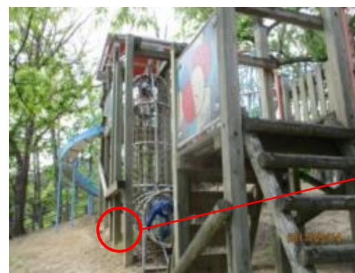
遊具の老朽化状況
