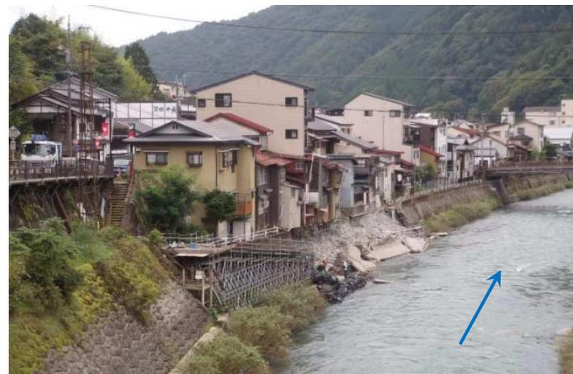
令和3年8月の大雨により護岸基礎が崩れ、護岸に沿って並ぶ家屋12棟で倒壊のおそれ
