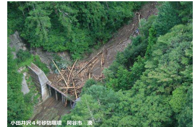
小田井沢4号砂防堰堤 岡谷市 湊 令和3年8月13日からの大雨により土石流が発生したが、砂防堰堤が整備されており、下流への被害を未然に防止
