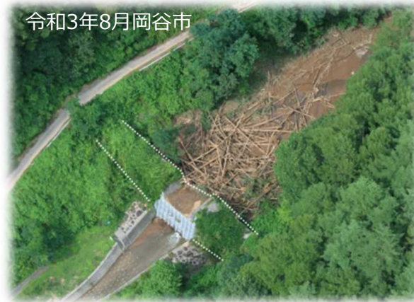
砂防堰堤により、下流への被害を未然に防止
