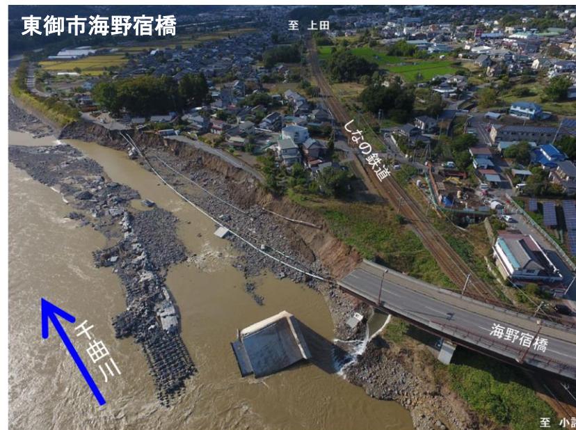
河川護岸の欠損と道路橋の損壊により鉄道が運休。 災害に強いインフラの整備が求められている。
