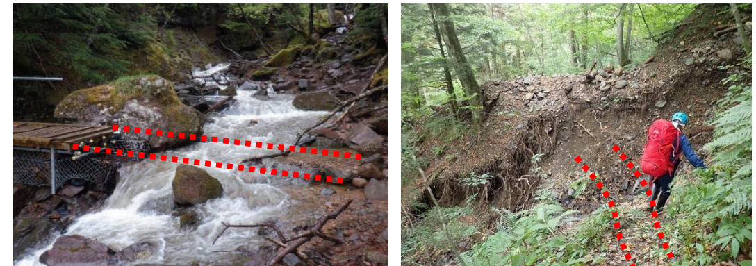
豪雨によって損傷した登山道
