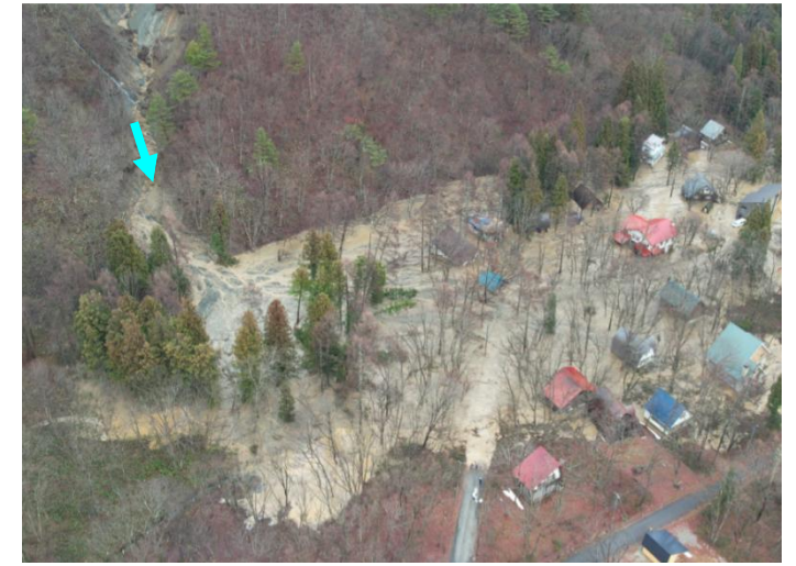
白馬村黒豆沢 令和5年12月の大雨により土石流が発生 多くの家屋被害が発生した
