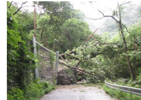
法面崩落による通行止め
