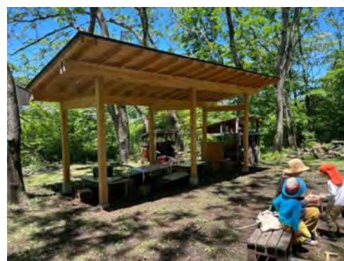
▲付帯施設として東屋を設置 (佐久穂町)
