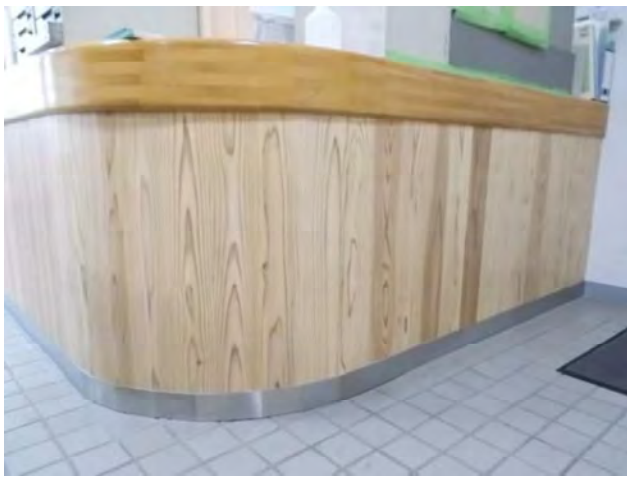
▲長野南警察署受付カウンター 木質化（長野市）
