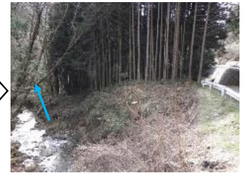
県管理河川の除間伐（木曽町 一級河川桂川）
