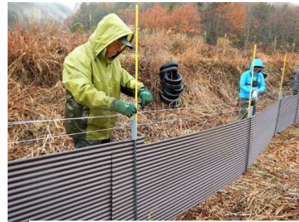
【電気トタン複合柵の設置】
