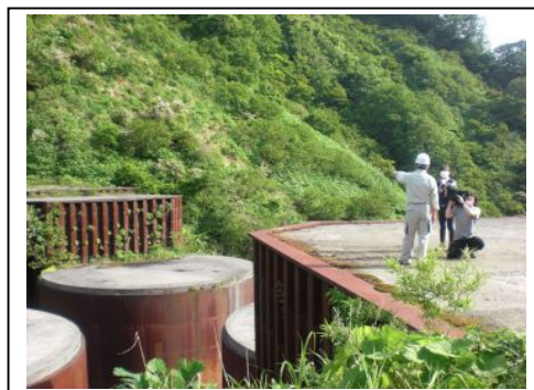
【土谷川奉納鋼製セル堰堤撮影中】
