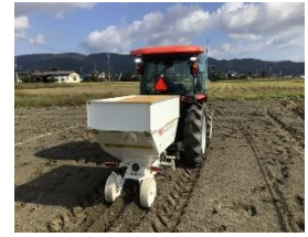
【もみ殻暗渠の施工状況】
