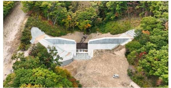
大町市布引沢の上手2号砂防えん堤
