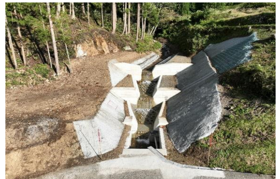
小谷村阿原工区で竣工した床止工
