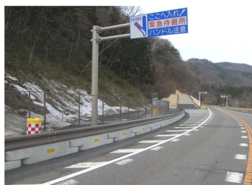
緊急待避所設置 (国道153号阿智村智里)
