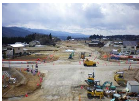
飯島地区の工事状況
