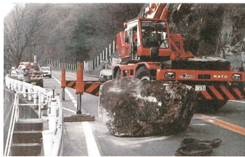
落石災害の状況（平成9年）
