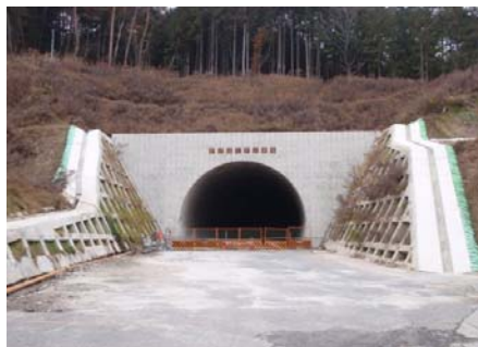
棧トンネル坑口
