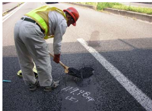
道路維持作業（舗装補修）
