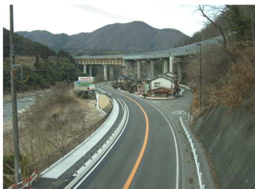
歩道設置 (国道153号阿智村駒場)
