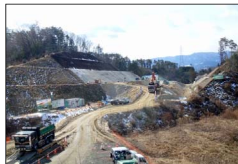
龍江地区の工事状況
