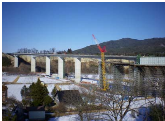
国道153号 伊南バイパス
