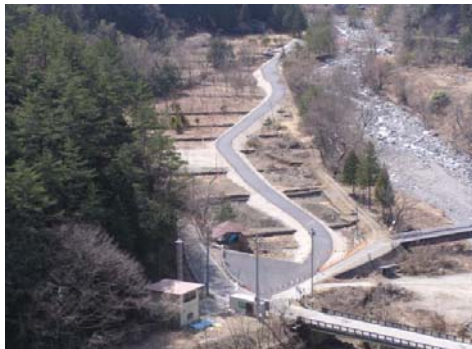
工事用道路工事状況 (飯田市南信濃八重河内)
