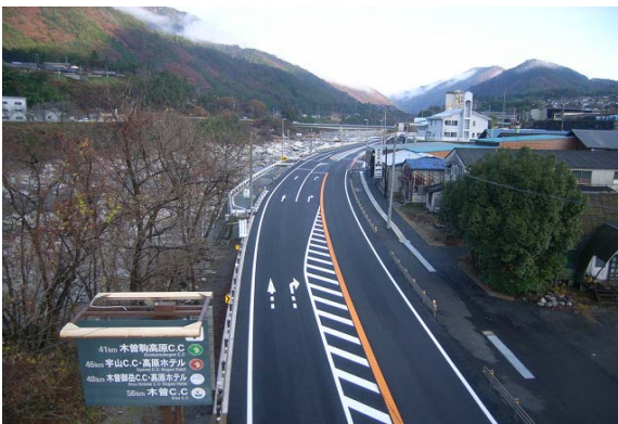
国道19号 交通安全事業(交差点改良) 南木曾町
