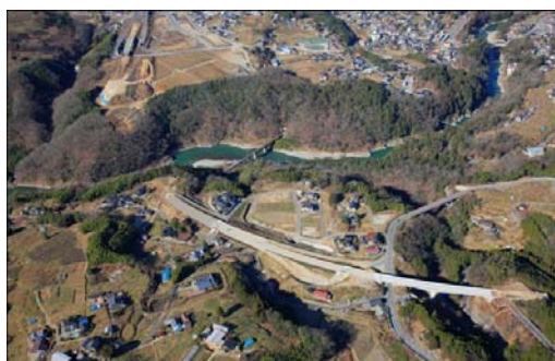
千代IC(仮称)の工事状況
