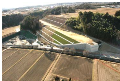
田切地区の工事状況
