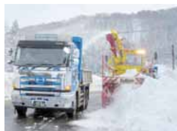
安全確保のための除雪作業(国道117号)
