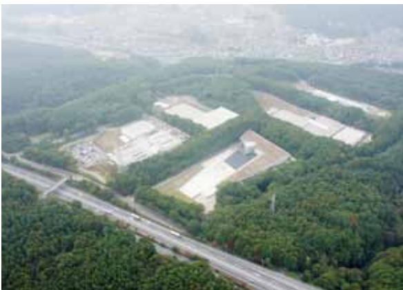
諏訪南IC付近に造成された林間工業団地
