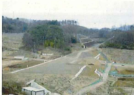
整備が進む中部横断自動車道（佐久市白田地区）
