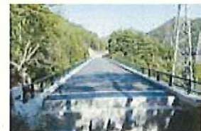
木曾右岸道路 (南木曾町川向わらび沢大橋)
