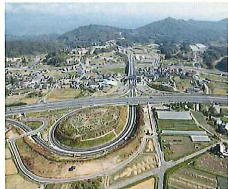
三遠南信自動車道 飯喬道路(飯田市)
