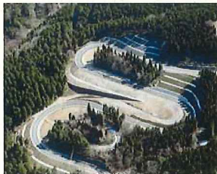
国道256号 (南木曾町清内路トンネル下)
