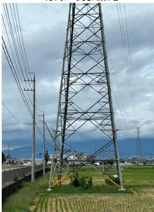
A方向から見た鉄塔
