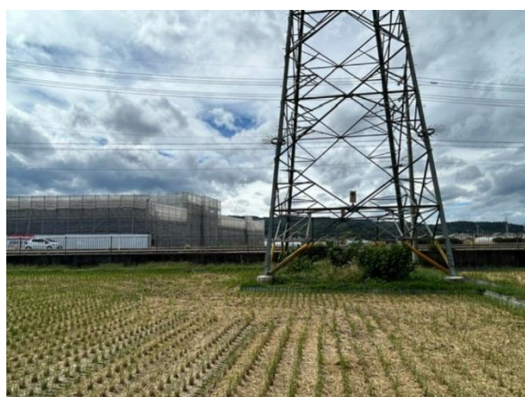
B方向から見た鉄塔
