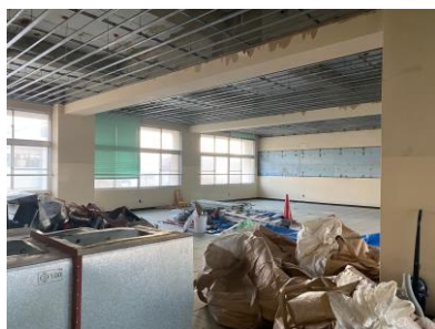
内装撤去作業中
