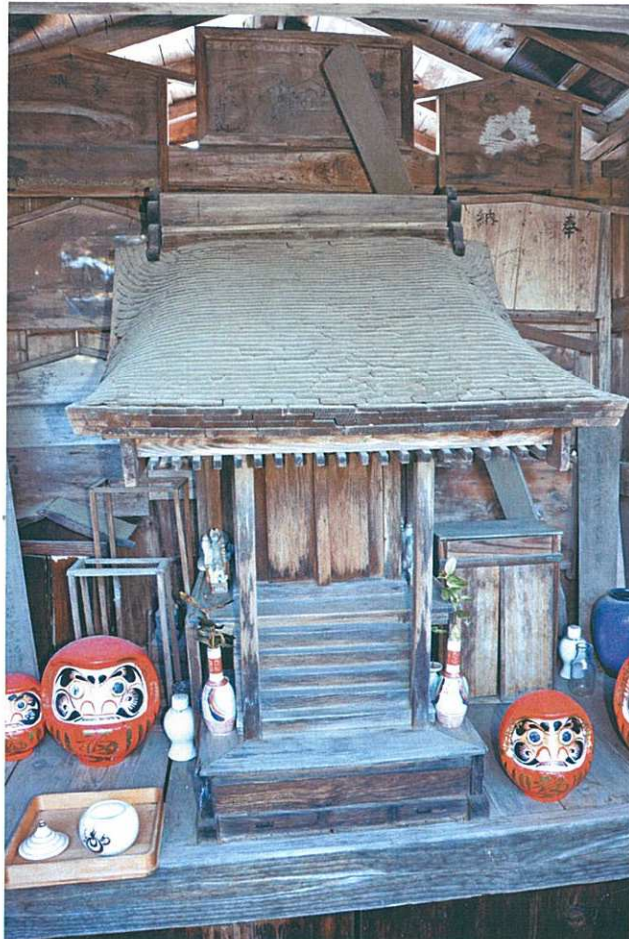
小田切家所蔵 高遠城二ノ丸廐稻荷本殿（平成26年3月8日撮影）
