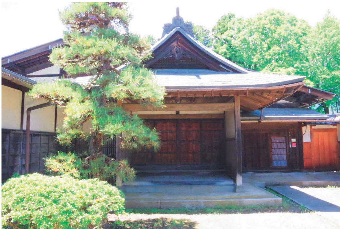
小町谷家住宅 主屋東側外観 (2018年撮影)
