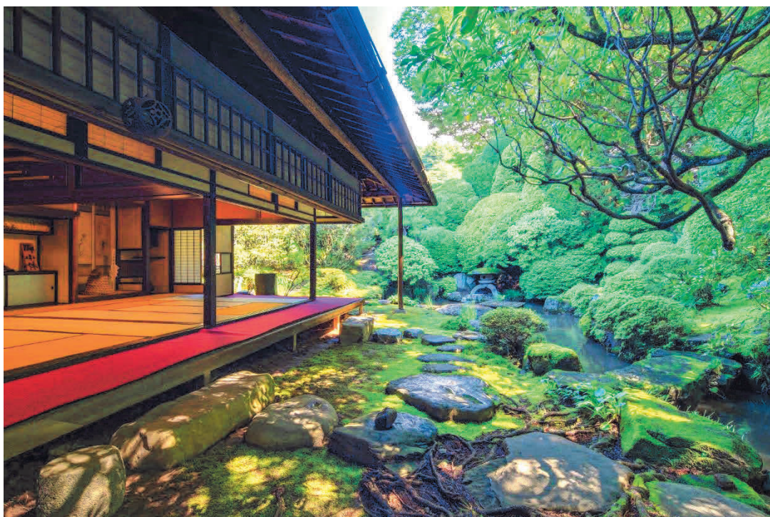
主屋南側外観と泉水石組
