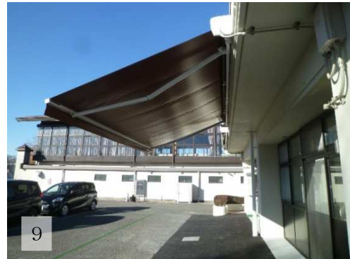
段差がなく、可動式のひさしがある送迎スペースのイメージ
