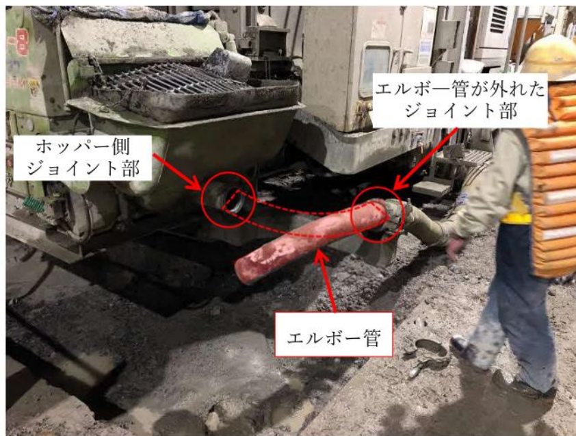
図 1 - 3 現地写真 (事象発生直前の状況を再現)
