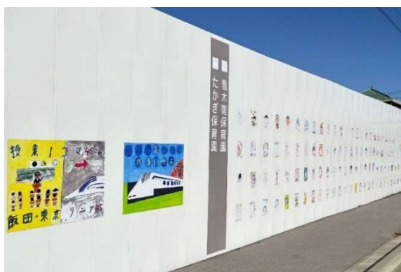
仮囲いに絵が展示されている様子(喬木村)
