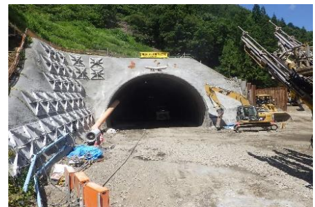
国道158号狸平トンネル工事(松本市)
