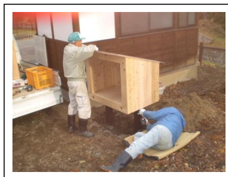
【エンカルボックス設置作業】
