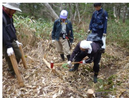
【ボランティアによる階段設置作業】
