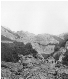
崩壊した泥沢の中部
