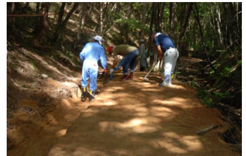
【遊歩道施工の様子】
