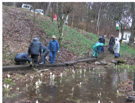
【遊歩道整備・新設】
