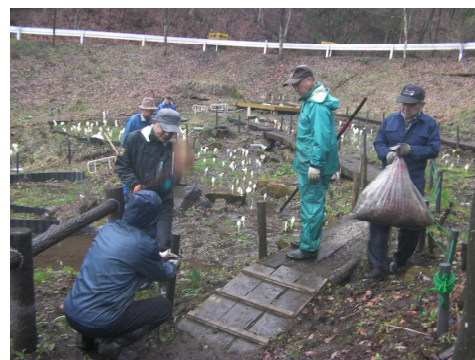
【遊歩道整備・丸太杭交換】
