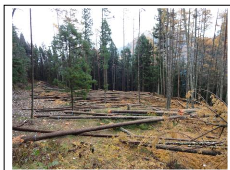
支障木伐採中
