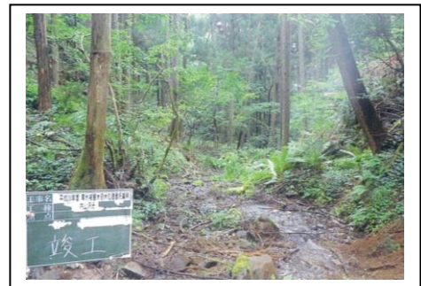
【河川内倒木除去後の状況】
