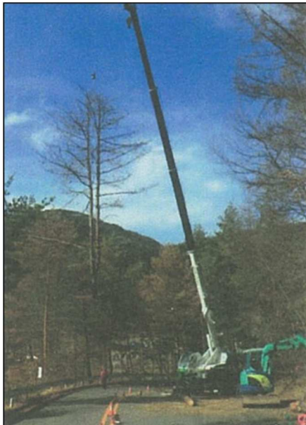
クレーン車による伐採
