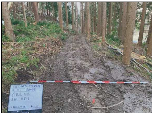
森林作業道開設
